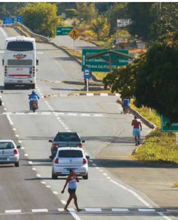
Faixas de pedestres na Rodovia BA-099, administrada pela Concessionária Litoral Norte.
