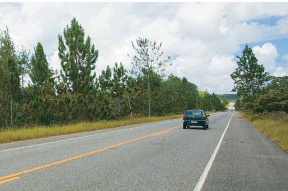
Rodovia BA-099, administrada pela CLN, liga a cidade de Lauro de Freitas à divisa dos estados da Bahia e de Sergipe.
